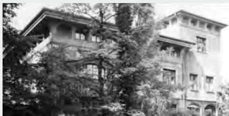
Romanstraße München, erstes Domizil der Fraunhofer-Gesellschaft © Fraunhofer
