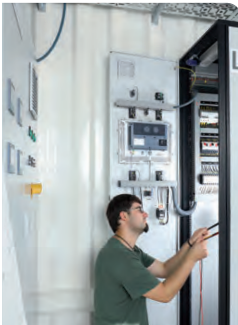
Ein IISB-Techniker bereitet einen Schaltschrank für den Einbau hocheffizienter und ultrakompakter Gleichstromwandler vor. © Fraunhofer IISB/ Kurt Fuchs
